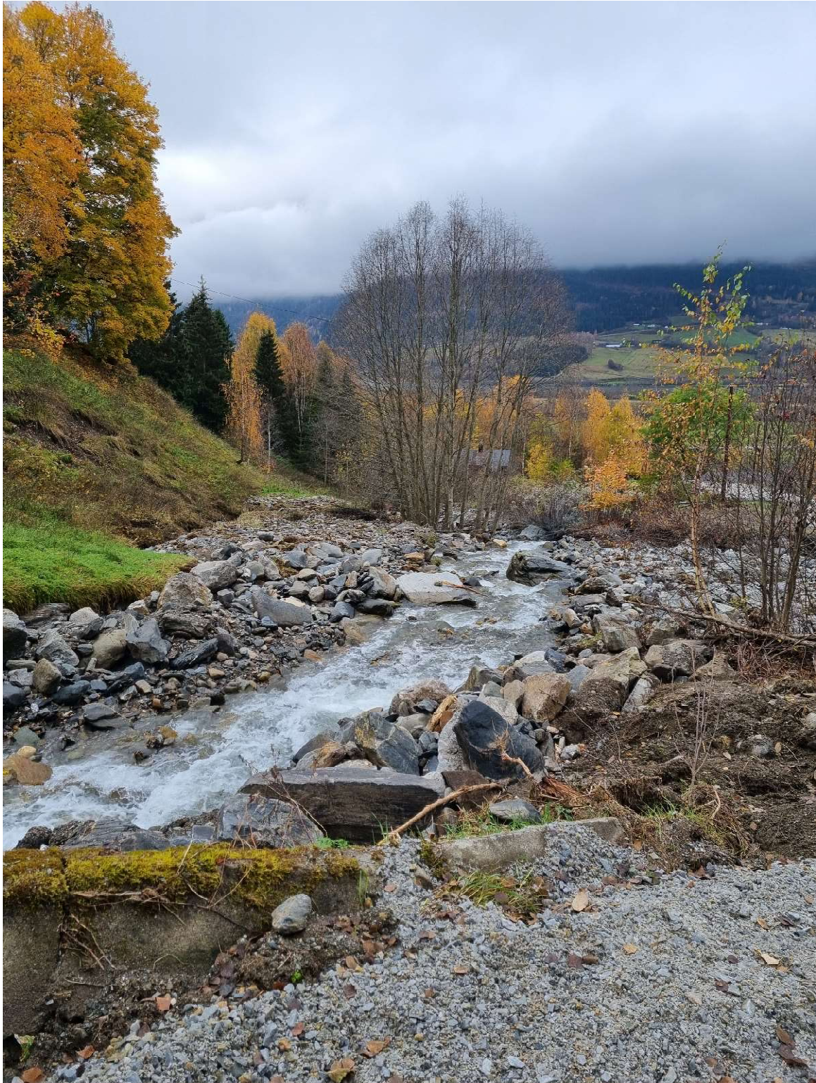
Figur 8: Nedstrøms kulvert Thujordsvegen Foto: NVE 16.10.24.
