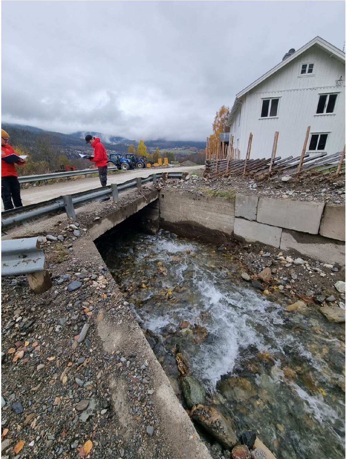
Figur 7: Mur fra Tromsnesvegen, og oppstrøms forbi Kirkestuen må tilstanden vurderes. Masser fjernes i kulvert. Foto NVE 16.10.24
