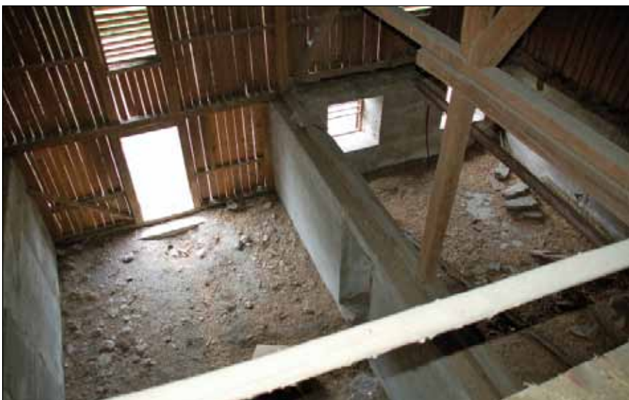
Fra høygulvet, åpent ned i kjelleren
