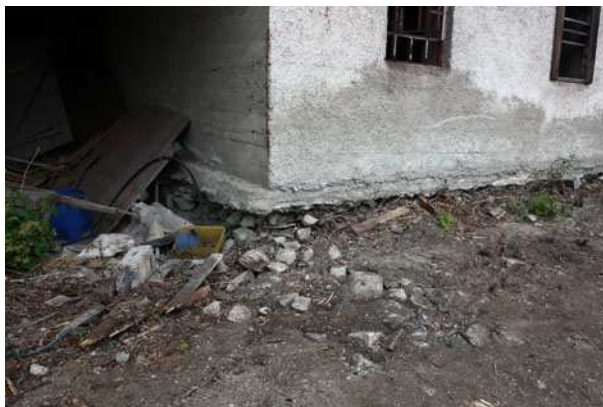
Grunn fundamentering i høve nytt terreng utanfor.
