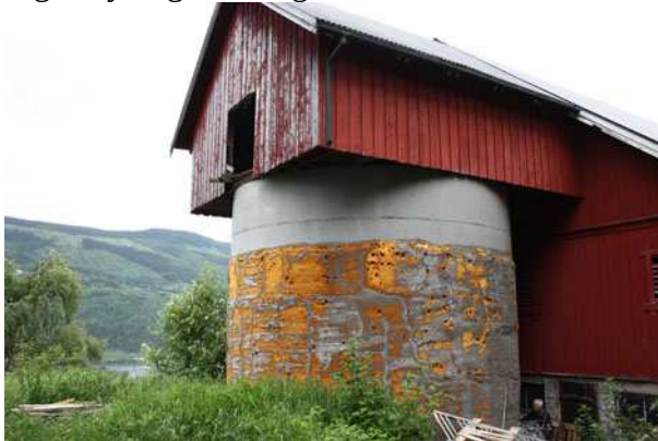
Førsilo utvendig på sør-sida. Isolert med skum.
