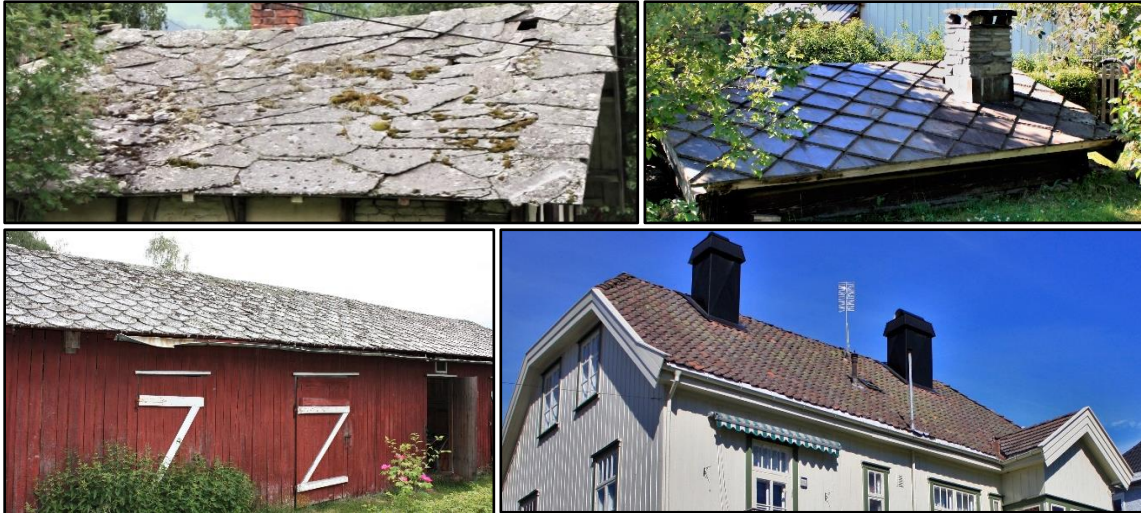
Øverst til venstre villskifer, til høgre firkantskifer, under til venstre handskebak skifer, under til høgre tegl.
