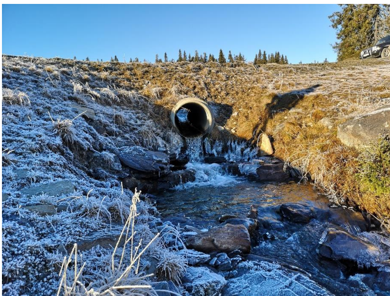
Utløps fra dagens stikkrenne (800 mm) under Svartskardvegen
