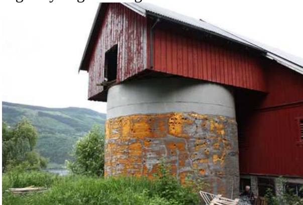
Førsilo utvendig på sør-sida. Isolert med skum.
