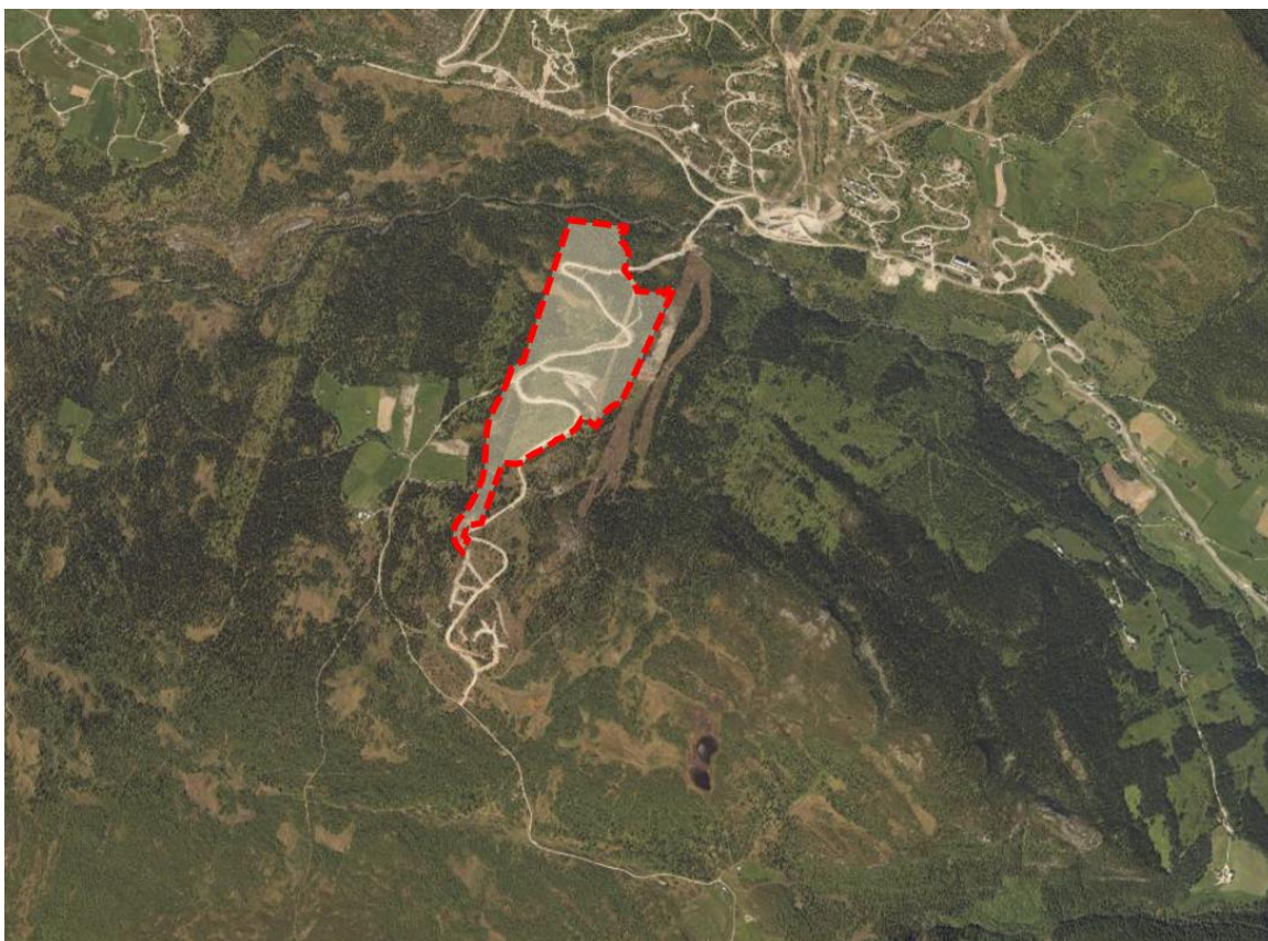
Figur 6 Ortofoto som viser arealet i 2017, der utbygging av ny veg, heiser og bakker mv er under bygging ( www.norgebilder.no )
