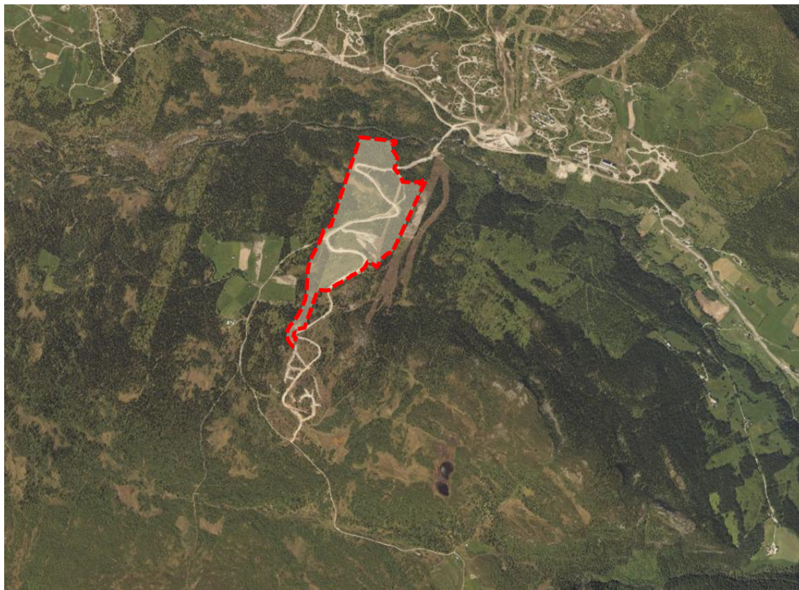
Figur 4 Ortofoto som viser arealet i 2017, der utbygging av ny veg, heiser og bakker mv er under bygging ( www.norgebilder.no )
