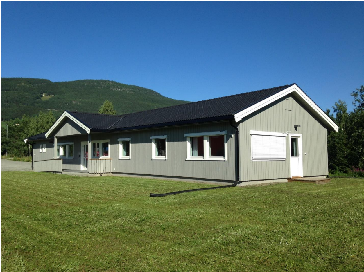
Nytt adm.bygg på Frya miljøstasjon.
