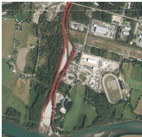
Figur 10. Flybilde med dagens sikringstiltak (rød).
