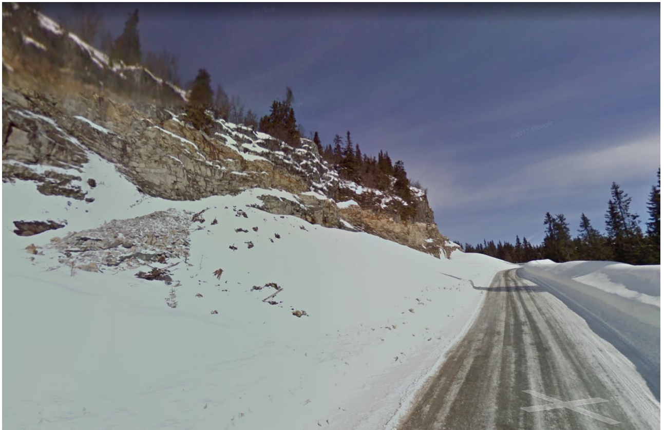
Figur 5 Svartskardveien. Rensing av fjell og sikringstiltak vises
