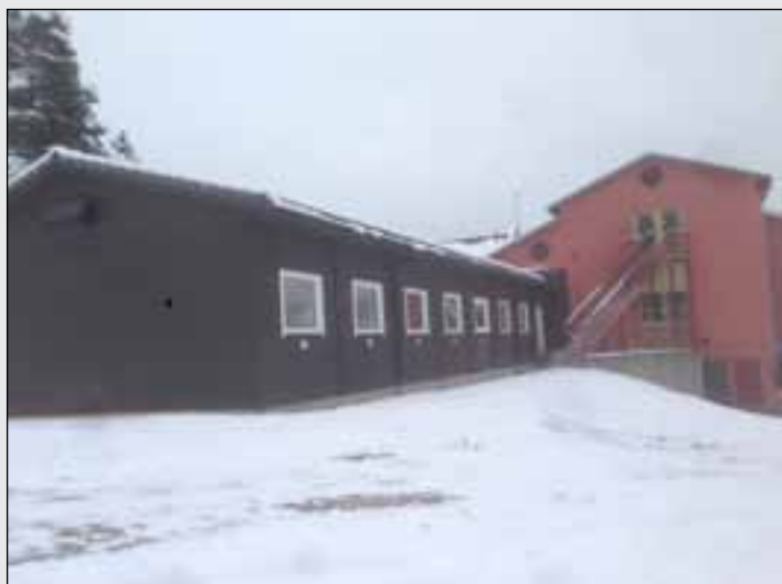
Fåvang skole med nytt tilbygg 2015
