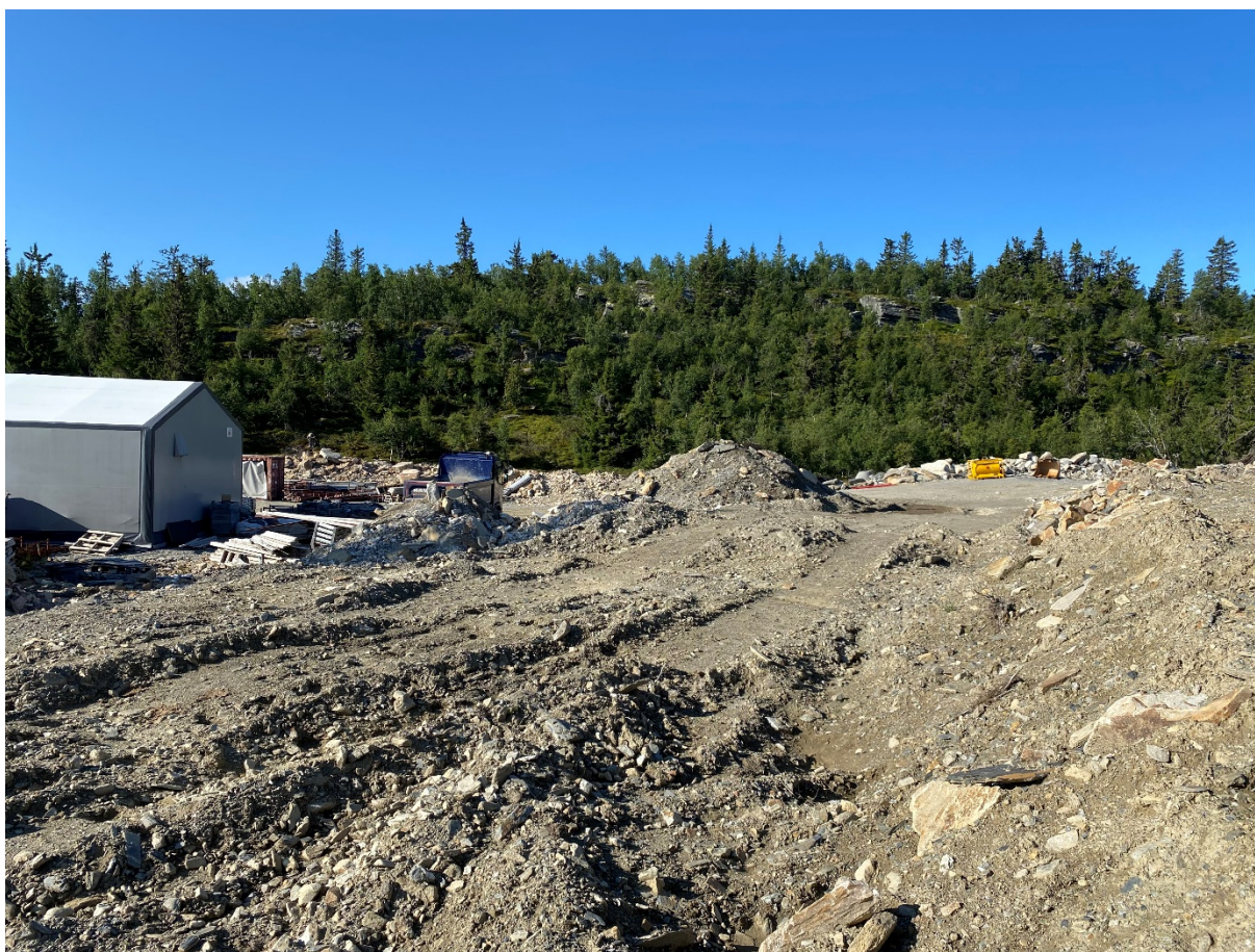
Figur 16 Anlegg og riggområdet i dag
