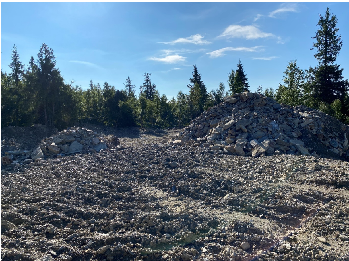
Figur 12 Anlegg og riggområdet
