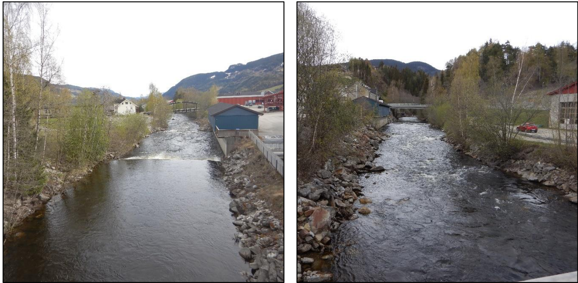
Figur 3: Bilder av elveløp langs planområdet sett fra opp- (v.) og nedstrøms side (h.). Bygg på motsatt side av elva er etablert på en støttemur i betong.
