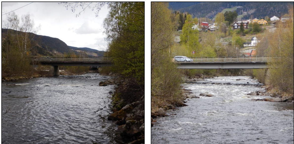
Figur 6: Bru ved E6 sett fra opp- og nedstrøms side.
