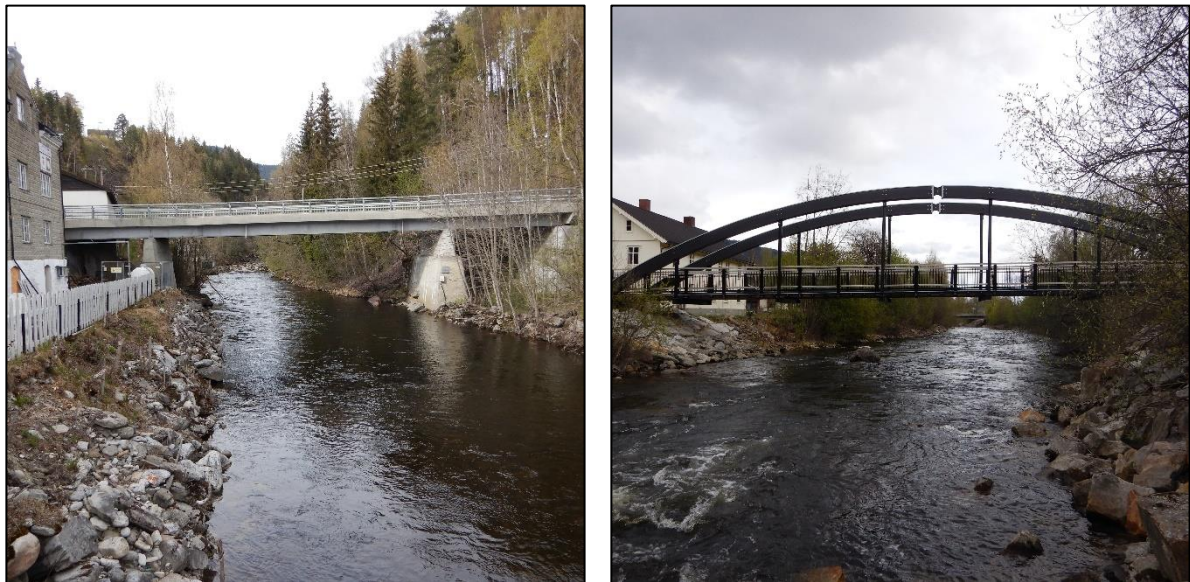
Figur 5: Bilde av bru ved Brugata (v.) og gangbru i nedstrøms del av planområdet (h.).
