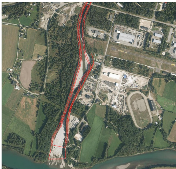
Figur 10. Flybilde med dagens sikringstiltak (rød).
