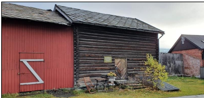
Figur 9: Uthus, stabbur, stall og nordleg del av fjøs, sett frå nordvest. Ein kan sjå restar av kor uthuset har stått på teglsteinsveggen til høgre.
