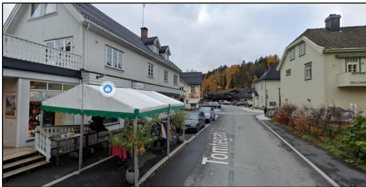
Figur 21: Tomtegate sett mot krysset til Jernbanegata. Salsboder i tilknytning næringsverksemd i 1. etasje.
