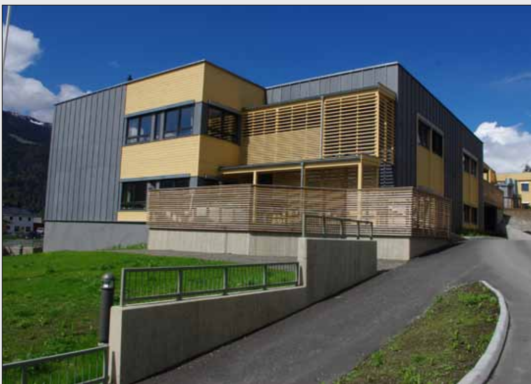
C-bygget er ferdig og utsikten kan nytes for fullt
