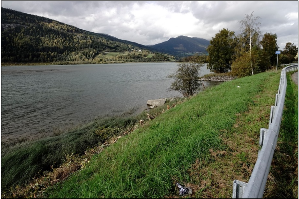
Figur 4. Østsida av utredningsområdet med E6 og tilhørende vegskråning. Skråningen skjøttes med regelmessig kantslått. Foto: Geir Høitomt.
