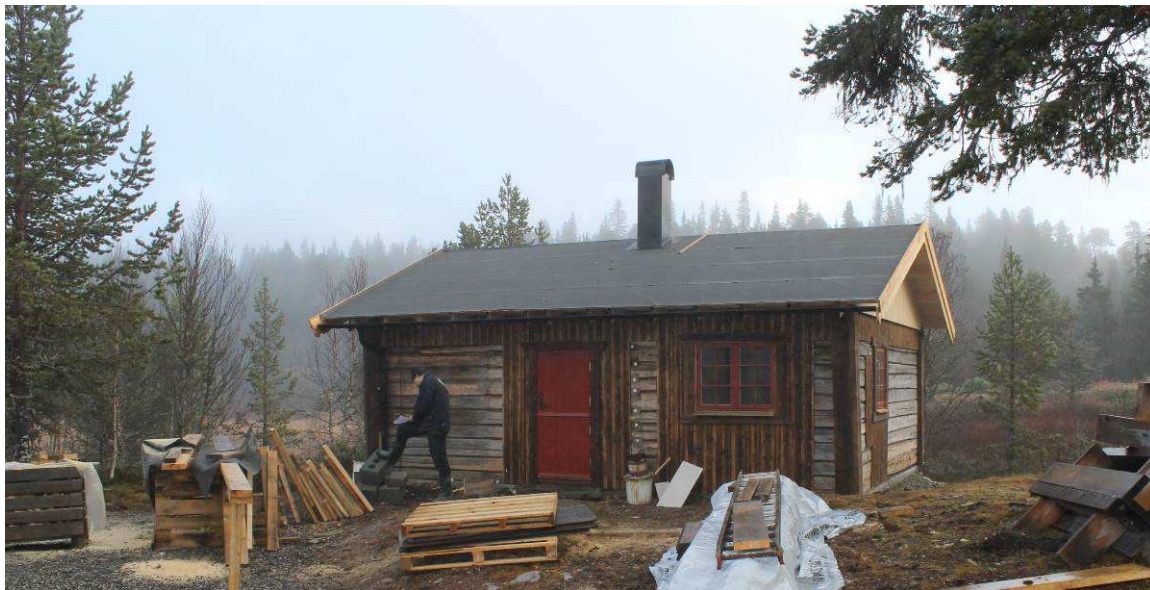
Serveringsstua «Jegern» under bygging høsten 2014
