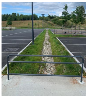
Figur 16 Tv: Åpne løsninger for fordøyning og infiltrasjon av overflatevann er også egnet for å tilføre grønt og strukturere parkeringsplasser. Eksempel fra Campus Ås.
