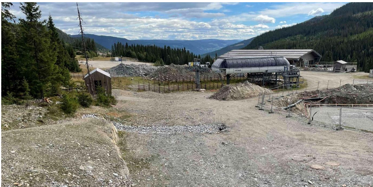
FIGUR 8 NYETABLERT GRØFT ENDER I 300 MM OV-LEDNING SOM LEDER VANNET RUNDT BYGG SOM ER UNDER OPPFØRING
