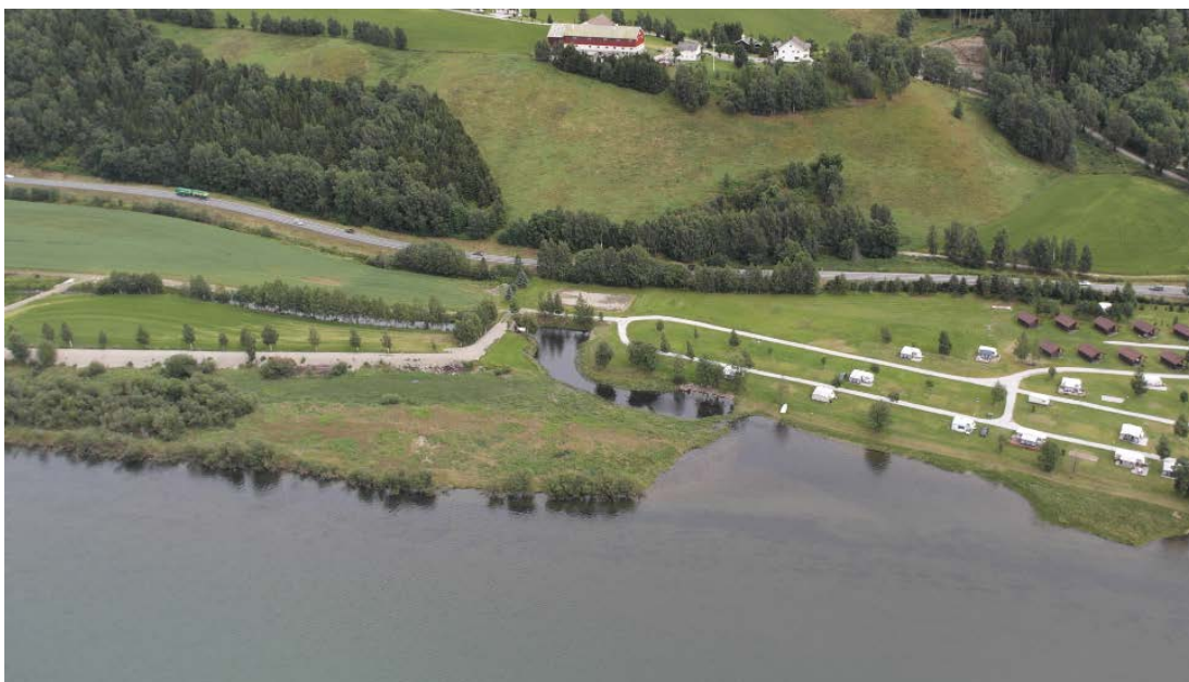
Figur 6 Kryssing av Elstadevja. Her ligger dagens pumpesystem for å pumpe ut vann fra dalsiden som kommer ned på innsiden av flomvollen. Det vil også være behov for pumpesystem i fremtiden. Det vil være nødvendig med en konstruksjon for å krysse evja.
